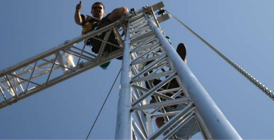
Jede Seite eines Dreiecks darf nur axialen Druck oder Zug erfahren. Da keine anderen Einflüsse wie z.B. Biegebeanspruchung angenommen werden, dürfen Lasten nur in die Knoten eingeleitet werden. Traversen der 30er-Serien besitzen relativ große Fachwerkstreben im Vergleich zur Bauhöhe der Traverse und ein verhältnismäßig dichtes Fachwerk.
